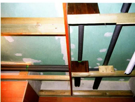
↑ Над каркасом потолка проходят полипропиленовые трубы водопровода дома.
