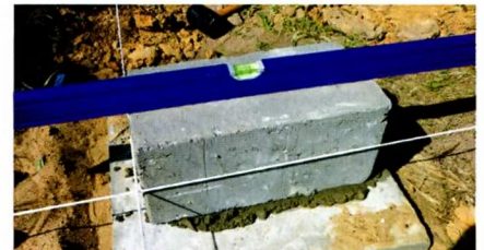
↑ Правильность установки блоков контролировали при помощи уровня.
