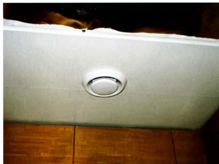
↑ Анемостат вентиляции в сборе на потолке из ПВХ-панелей.
