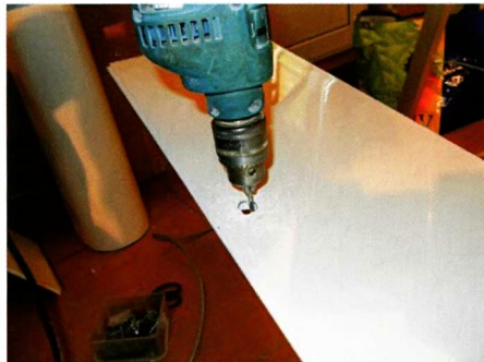
↑ При необходимости сделать отверстия ПВХ-панели фрезеруют обычным сверлом.
