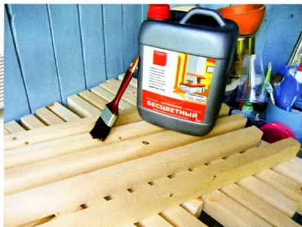
↑ Элементы деревянного каркаса потолка заранее обрабатывали антисептиком.
