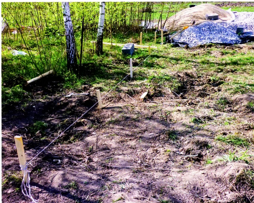
↑ Фундамент начинается с разметки.
