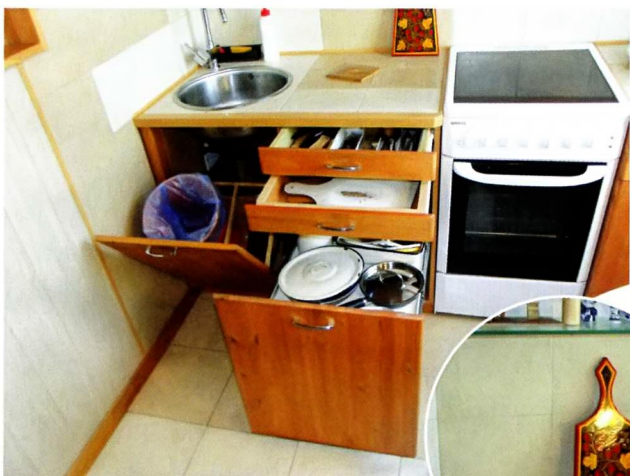
↑ Под мойкой — откидная секция для ведра; справа — выкатная секция и ящики. Рабочая поверхность и фартук отделаны керамической плиткой.
