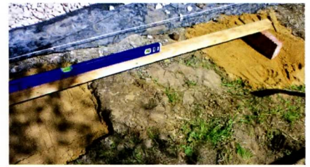
↑ Перед укладкой плит уровни всех подушек выровняли.
