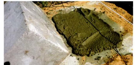
↑ Блоки укладывали на цементный раствор.
