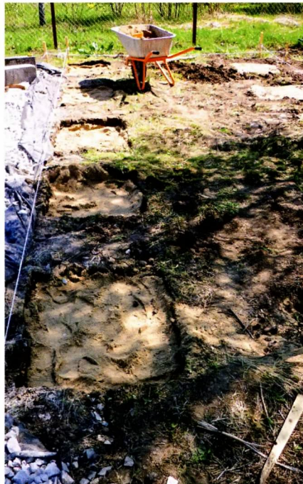
↑ Котлованы засыпаны песком и утрамбованы.
