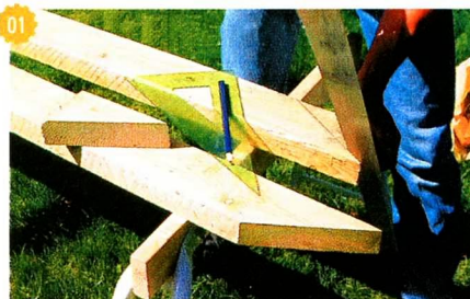
↑ Торцы всех стропил 1 размечают и запиливают на ус — с одной стороны под углом 60 градусов, с другой — под углом 30 градусов.
