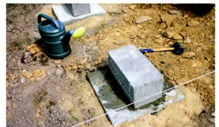
↑ Блоки устанавливали по шнуру.
