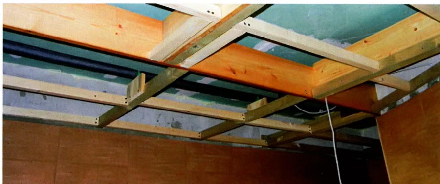
↑ Структура деревянного каркаса подвесного потолка.
