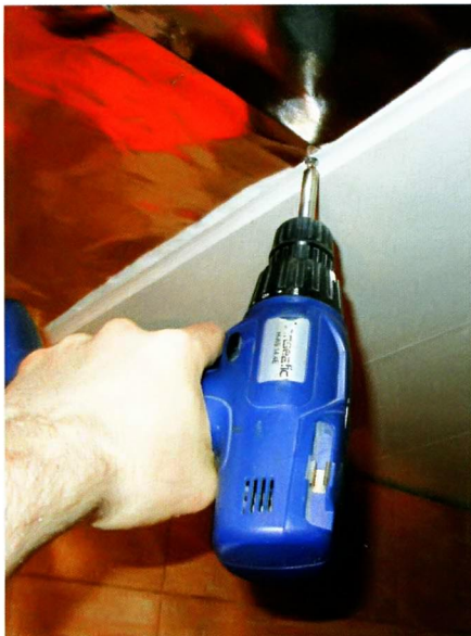
↑ Крепление панелей ПВХ саморезами.
