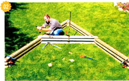
↑ Стропильные фермы собирают из стропил и ригелей 2 на ровной площадке. После изготовления первой фермы её используют как шаблон для сборки остальных.
