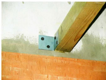
↑ Бруски каркаса потолка крепили к стенам с помощью стальных уголков.
