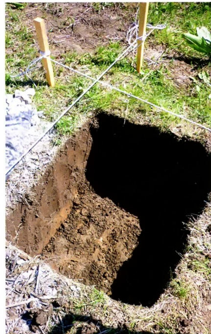
↑ Котлован под песчаную подушку рыли на глубину залегания плодородного грунта.
