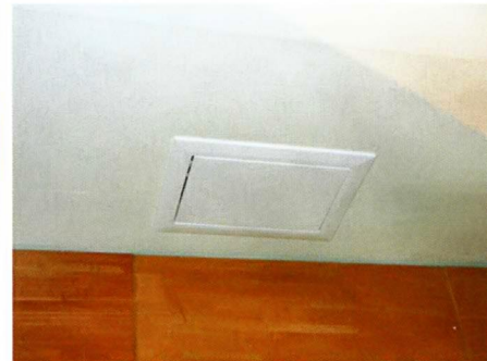
↑ Для доступа к распределительной коробке в потолок врезан ревизионный лючок.
